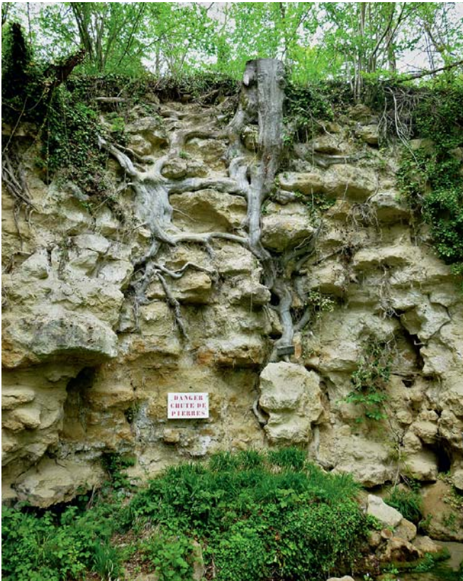
Réseau de racines de hêtre traversant les calcaires lutétiens en direction de suintements d'eau alimentant une des sources de l'Aubette de Magny, près de Nucourt.
