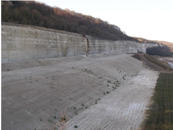
Réaménagement final du la carrière de Guerville classée Natura 2000 : les banquettes et talus supérieurs sont recouverts de craie et accueillent à nouveau des populations de Sisymbre couché présentes historiquement sur le carreau bas.
