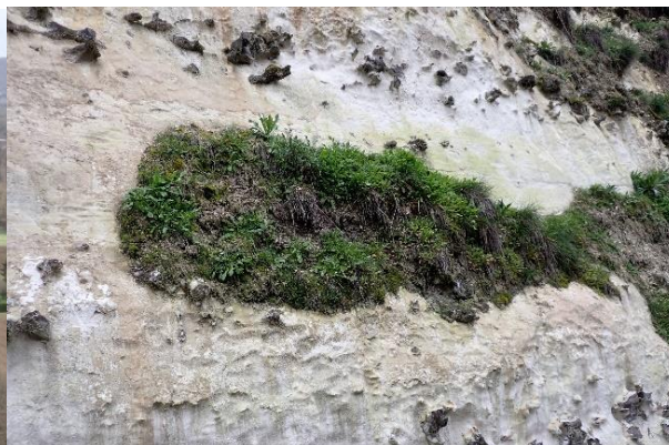
Figure 3 : Végétation sur paroi crayeuse © L. DAMAS- CBN du Bassin parisien
