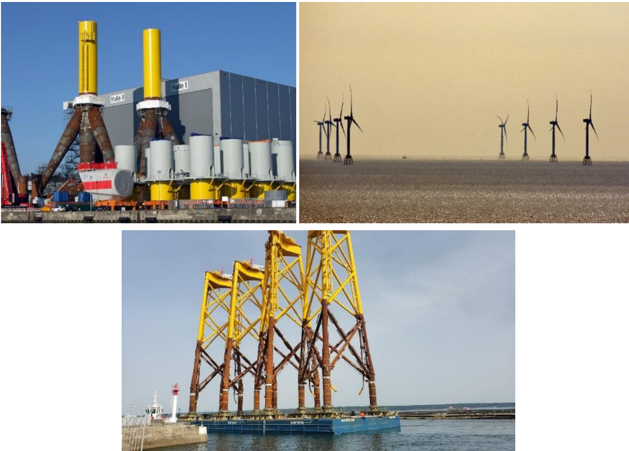
Figure 15 : (a) fondations tripodes. Port de Bremerhaven, Allemagne (photo : N. Klesy / Pixabay). (b) éoliennes sur fondations de type jacket. Champ éolien offshore Beatrice au nord-est de l'Ecosse (photo : B. Guichard / Office français de la biodiversité). (c) fondations jackets à trois pieds pour le parc éolien de Saint-Brieuc (photo : S. Michel / OFB).
