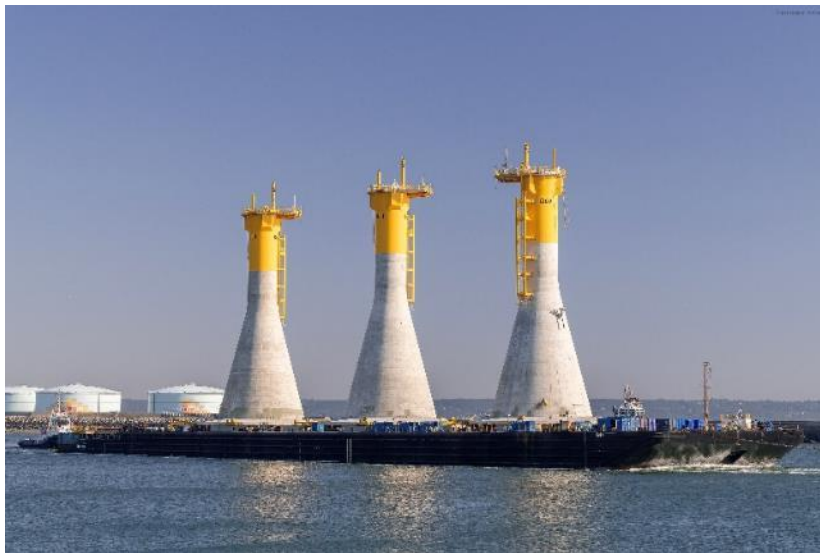
Figure 12 : Transport par barge de fondations gravitaires pour la construction du parc éolien en mer de Fécamp (©Alexandre Prevot, Wikimedia commons).
