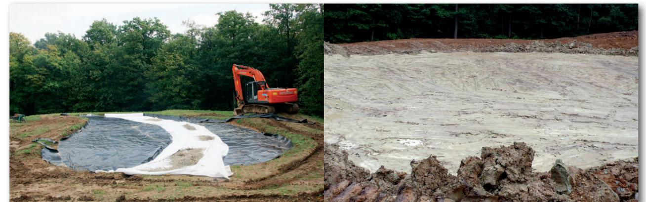
Étanchéité active et passive (membrane et 0,50 m d'argile) sous un green situé en amont d'un site Natura 2000. Les eaux drainées sont conduites en dehors du bassin versant vers une zone de rejet végétalisée. Le site Natura 2000 est préservé.
