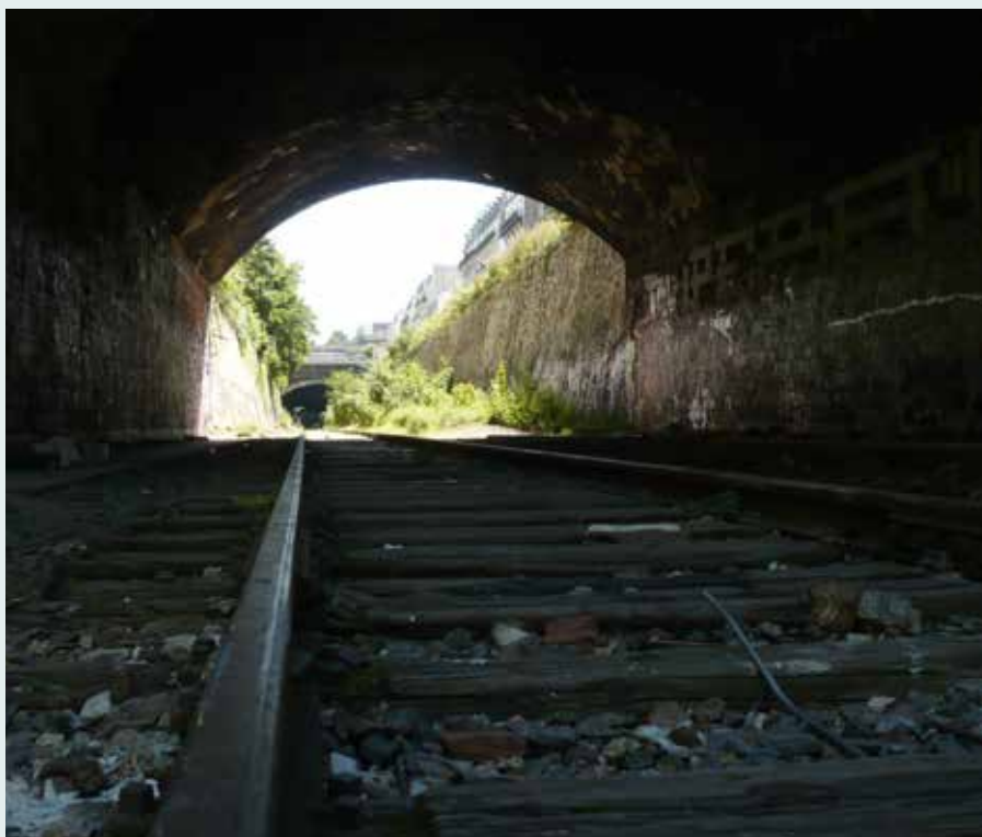
Tunnel de la petite ceinture prospecté lors des comptages de pipistrelles. © Xavier JAPIOT
