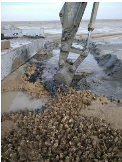
Figure 4 : (a) pelleuse marinisée spécialement conçue pour les travaux en substrat meuble. Elle est équipée de flotteurs, de 2 moteurs hydrauliques pour la propulsion et d'un broyeur automoteur. (b) opération de retrait des friches conchylicoles (crassats) en baie de l'Aiguillon (photos : RNN baie de l'Aiguillon, ONCFS-LPO).
