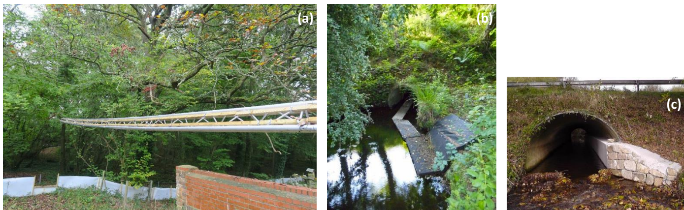
Figure 15. Illustrations de différents aménagements mis en place en Bretagne : (a) passage à petits rongeurs, (b) banquette à loutre et (c) ponton flottant © Groupe Mammalogique Breton
