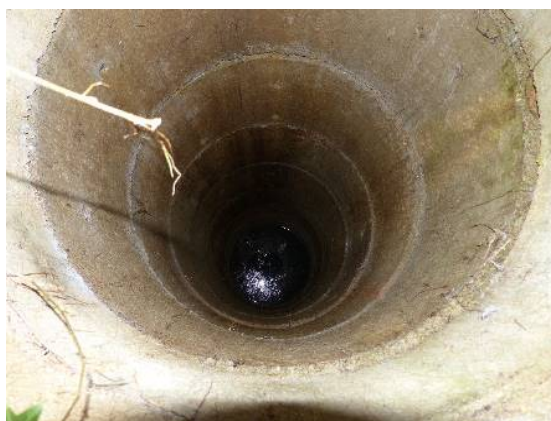
Figure 41 - Exemple : puisard en béton piégeant pour les Grenouilles rouges © O. Delzons
