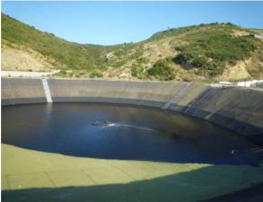
Figure 38 - Exemple : Bassin bâché avec des berges très abruptes, mais équipé d'un dispositif de type « échappatoire à faune » (en clair, au fond) © O. Delzons
