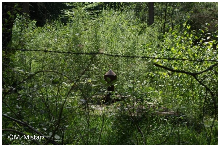
Photo 25. Captage d'eau potable sur un site Natura 2000.
