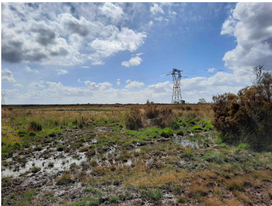
Ligne haute tension traversant le site – 21/05/2021 – Cliché G. Ferrère
