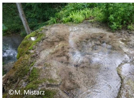
Photo 11. Piétinement d'un massif tufeux dans l'Aisne (Fontaine Saint-Martin).
