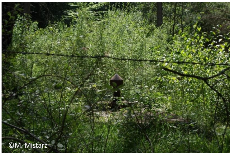
Photo 9. Captage d'eau potable sur un site Natura 2000 présentant des habitats tourbeux.
