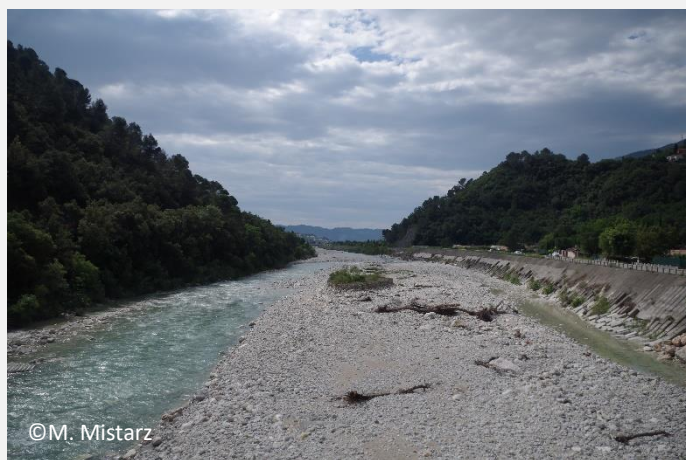
Photo 24. Endiguement sur l'Estéron.
