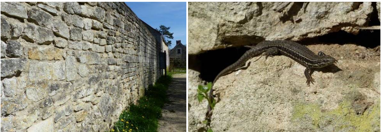
Figure 22 - Mur d'enceinte en pierre et Lézard des murailles observé en train de thermoréguler aux heures les plus chaudes d'une après-midi de printemps © O. Roquinarç'h
