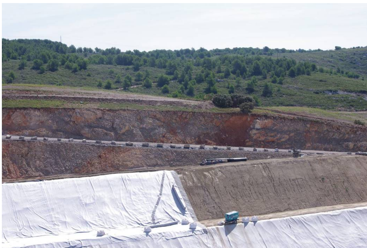
Figure 24. Exemple de surface très artificialisée sur une installation de stockage de déchets : au premier plan : talus nus, zones bâchées ; les espaces plus naturels en arrière-plan se situent hors du site © O. Delzons
