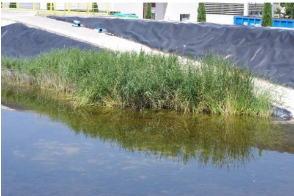
Figure 39 - Exemple : bassin d'eau pluviale bâché, partiellement végétalisé avec une rampe en béton permettant l'accès de la faune et constituant une échappatoire © O. Delzons
