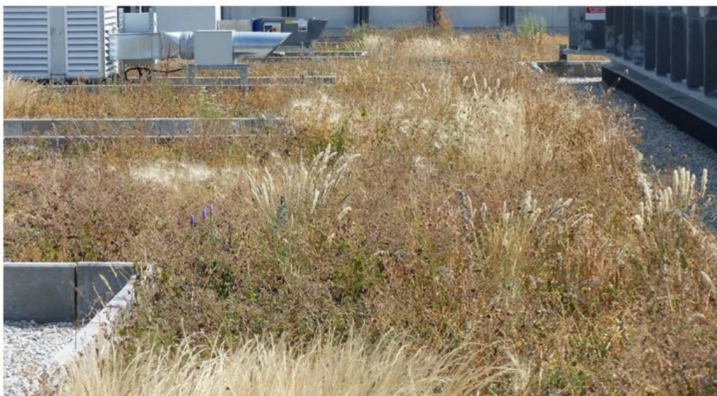
Figure 53 - Exemple d'une toiture végétalisée avec un cortège végétal mixte (spontané/semé/planté) © O. Roquinarc'h
