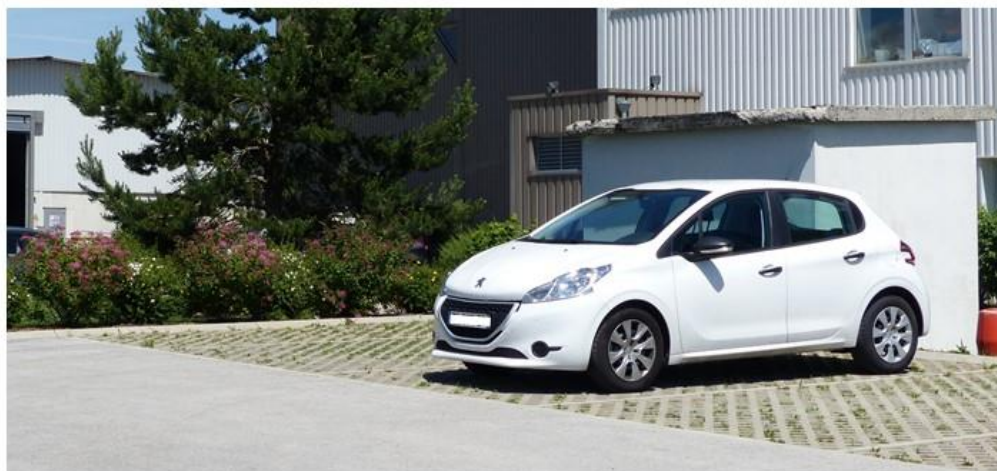
Figure 63 - Végétalisation partielle de places de parking © C. Thierry
