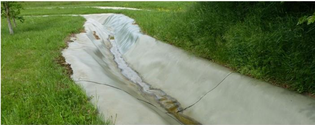
Figure 29 - Réseau bâché pour éviter l'infiltration d'eaux chargées © O. Roquinarç'h
