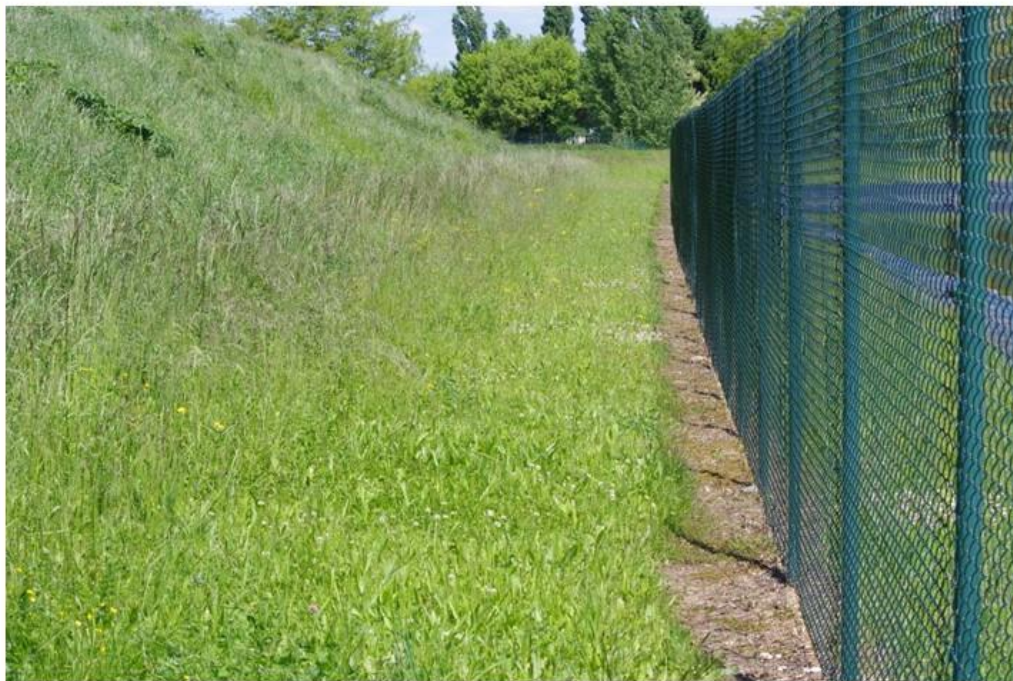
Figure 37 - Pied de clôture désherbé chimiquement © O. Delzons
