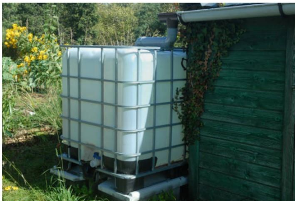
Figure 60 - Récupérateur de pluie à partir d'une gouttière © iStock
