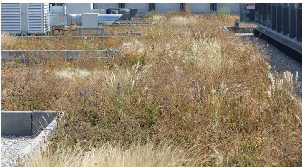
Figure 53 - Exemple d'une toiture végétalisée avec un cortège végétal mixte (spontané/semé/planté) © O. Roquinarç'h
