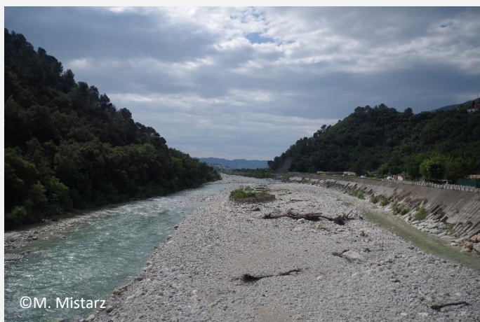
Photo 2. Endiguement sur l'Estéron.
