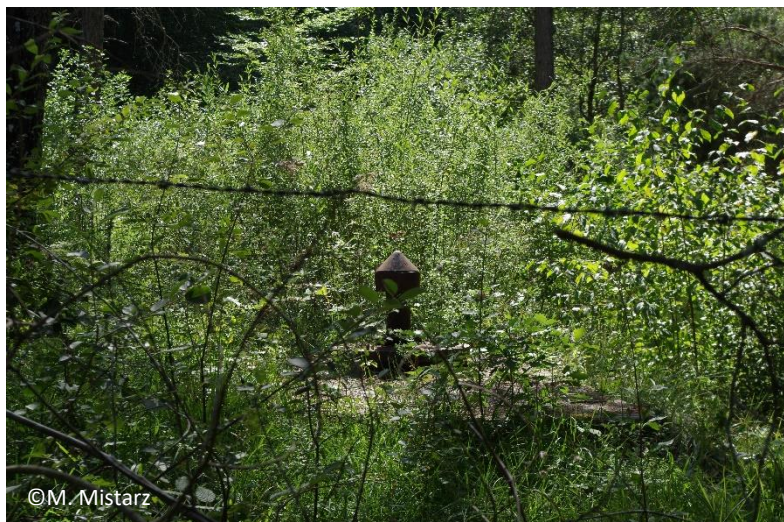
Photo 16. Captage d'eau potable sur un site Natura 2000 présentant des habitats tourbeux alcalins.
