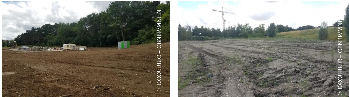
Figure 4 : Site de démolition et de construction respectivement au Nord (gauche) et Nord-Est du parc (droite)
